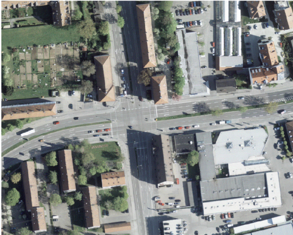
Abbildung 41 Luftbildausschnitt Knotenpunkt Goethestraße / Schillerstraße (Quelle: Stadt Ingolstadt)
